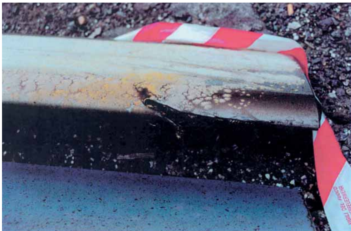
Particolare della fessurazione su una delle pale del rotore.
