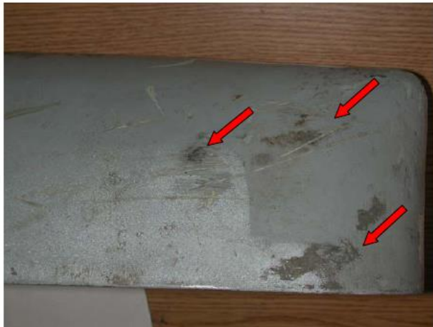
Figura 20 – Corrosione superficie inferiore massa equilibratrice
