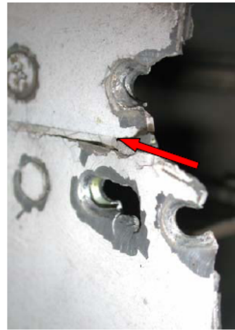
Figura 24 – Particolare rottura fori
