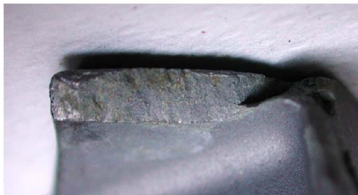
Figura 9 – Corrosione su zona rinforzo
