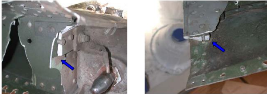
Figura 11 – Rottura flangia bordo d’entrata Figura 12 – Rottura flangia bordo d’uscita
